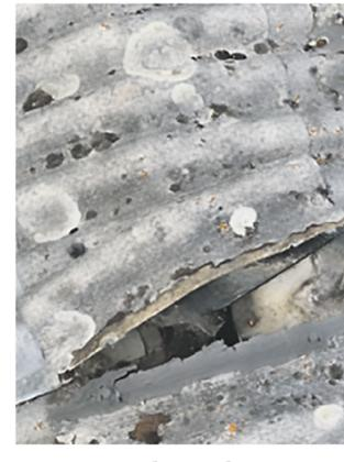
Eines von vielen Löchern im Asbestdach
