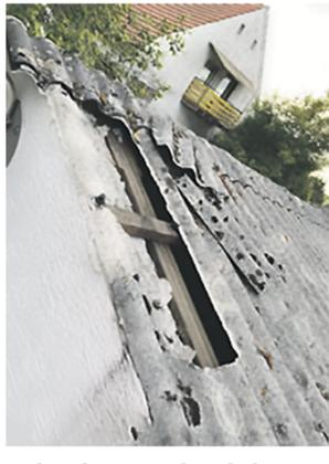
Gebrochenes und undichtes Asbestdach
