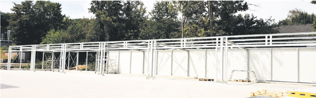
Baustelle (Bild: HK Pictures)
