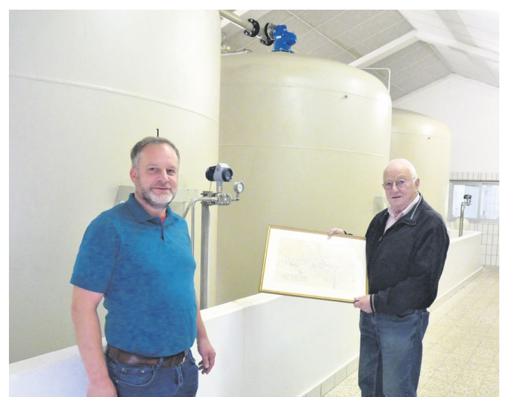
Die Niedernhausener Wassermeister Heiko Ströher und Friedel Dörr an den großen Tanks des Wasserwerkes Farnwiese
