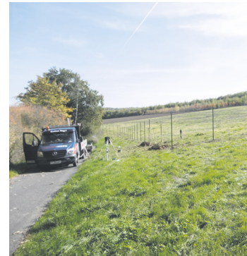
Der Bau des Solarparks Rabenwald hat begonnen.
