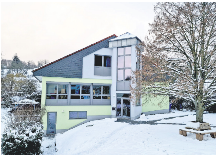
Der renovierte Kindergarten Engenhahn (Bild: HK Pictures)
