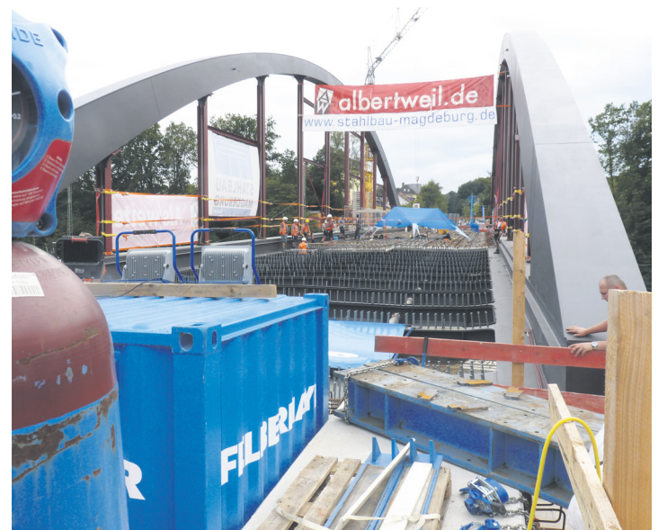
Fest im Widerlager verankert – die Stahlbogenbrücke von Niedernhausen
