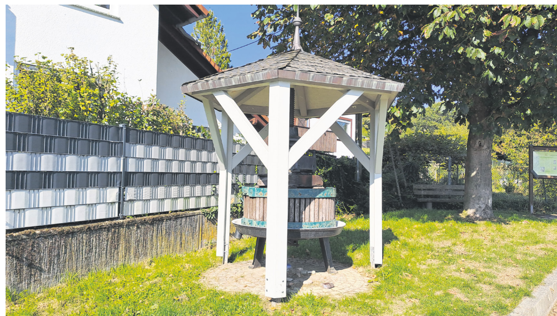
Der Kelterpavillon nach der Renovierung
