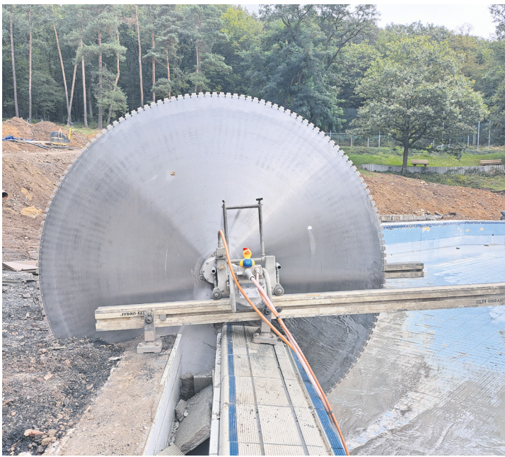
Spezial-Säge im Einsatz bei der Angleichung der Beckenköpfe (Bild: Gemeinde Niedernhausen)
